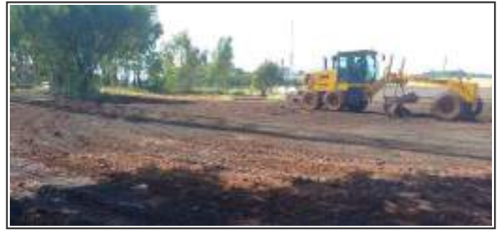
Com a trégua das chuvas, trabalhos de obras foram intensificados
