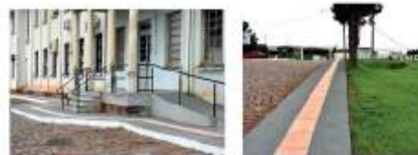
Calçadas da frente do prédio receberam piso tátil e está sendo instalado um elevador
