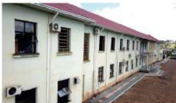
Estão sendo trocadas todas as janelas e portas do prédio
