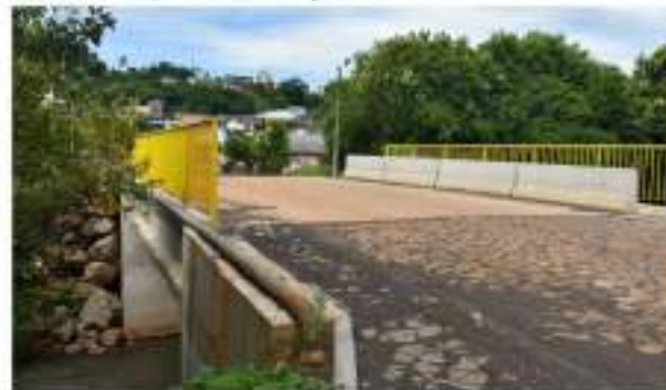
Ponte de concreto armado Rua Luiz Bergamini
