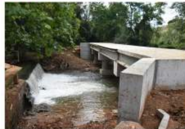
Ponte de concreto armado Rua Pedro Toniolo (Próximo Barragem da Corsan)
