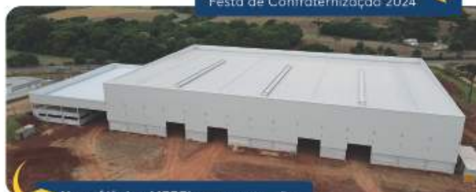
Nova fábrica MEPEL em construção às margens da RS 135 - Estação - RS
